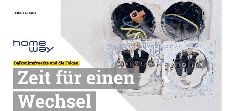
Balkonkraftwerke erzeugen eine neue Situation in Hausnetzen. Der zusätzliche Strom im Sicherungskreis kann zu den Verbraucherinnen und Verbrauchern gelangen, ohne über den Leitungsschutzschalter zu fließen. Je nach Verbraucheranordnung kann das an einzelnen Steckdosen zu Strömen führen, die deutlich über den abgesicherten 16 Ampere liegen.
